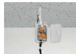
Conexión de lámpara en falso techo
